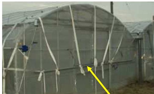
ハウスの出入口や天窓、谷間部分は補強材でしっかりと固定する。
