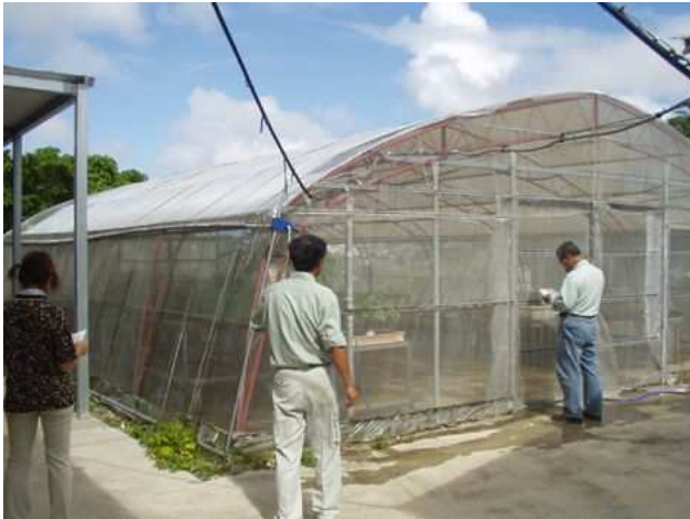
トラス構造を用いたハウス(那覇市)
