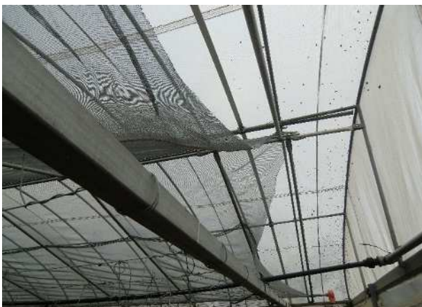
ハウス内部に遮熱ネットを被覆し、日焼け対策を施した事例(石垣市)
