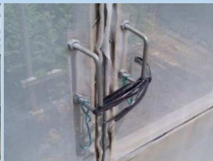
出入口の扉の固定
