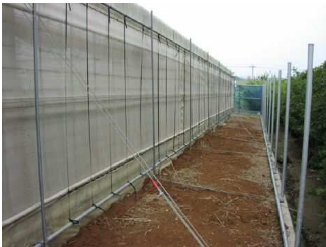
ワイヤーによる引張補強(宮古島市)
