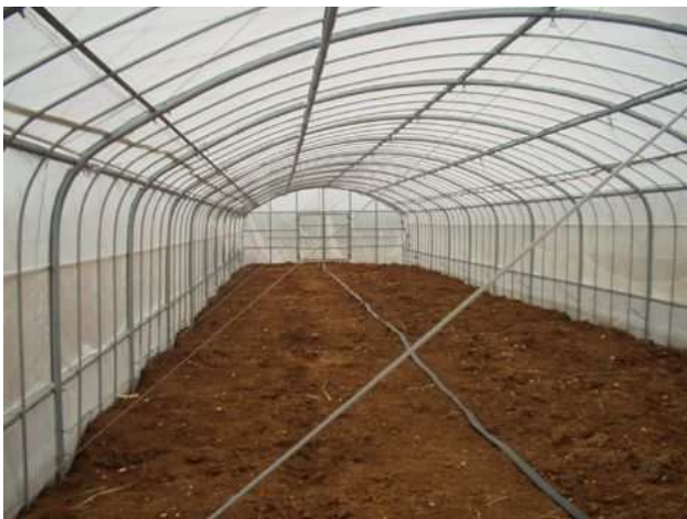
ハウス内にワイヤーを引張することもハウスの補強に役立つ(南城市)
