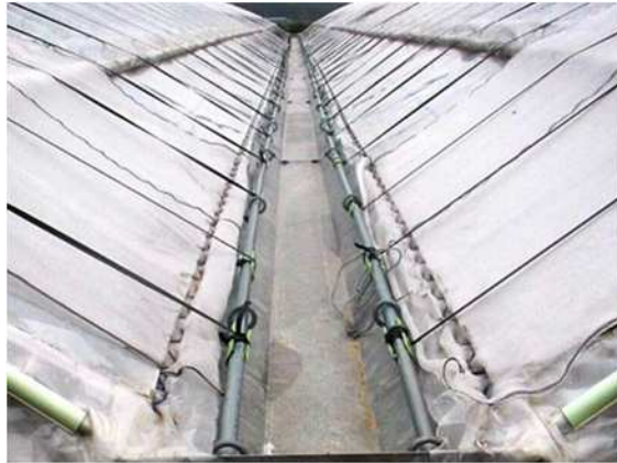
被覆資材の処理が良い状況
