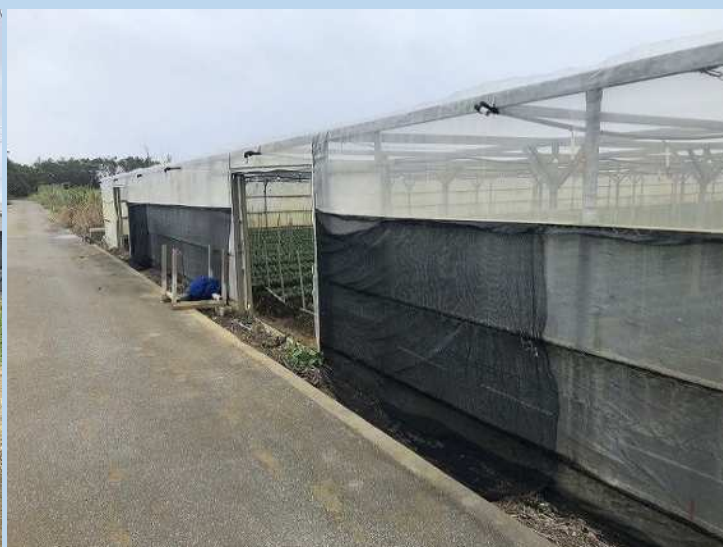
風上側の側面2重ネット対策(最上段は開けておく)
