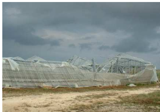
●施設の突風による倒壊
